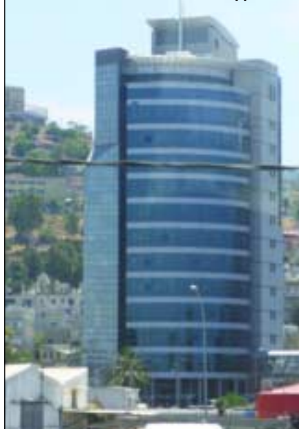
Полицейское управление в столице Израиля г.Тель-Авиве находится в современном высотном здании.
